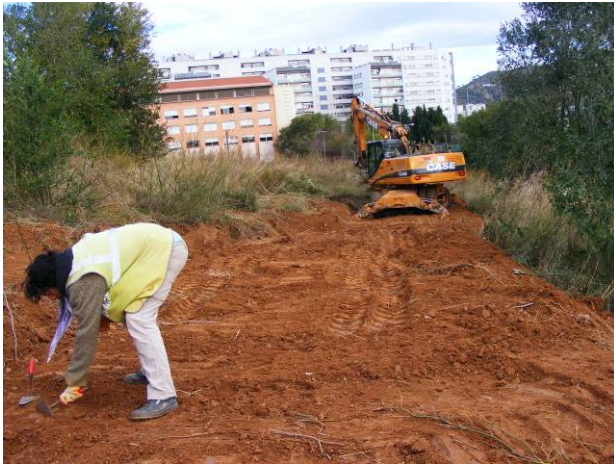
9. Realització de la rampa d'accés a l'àrea de sondejos.
