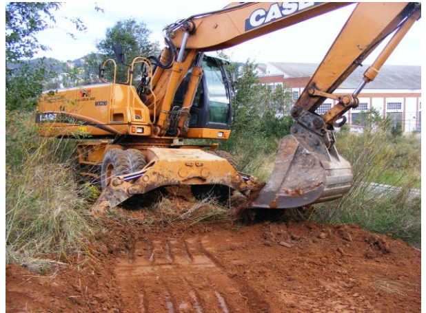
10. Neteja de l'àmbit de sondejos del costat sud.
