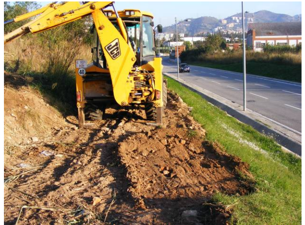
16. Inici de l'excavació del sondeig 100.
