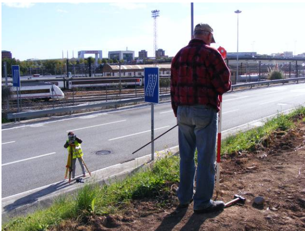
43. Replanteig del límit d'afectació de l'obra i de la vorada.
