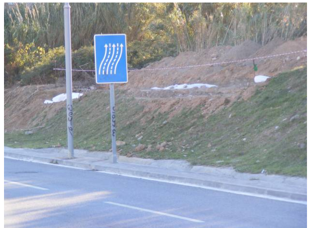
48. Geotèxtil cobrint les estructures..
