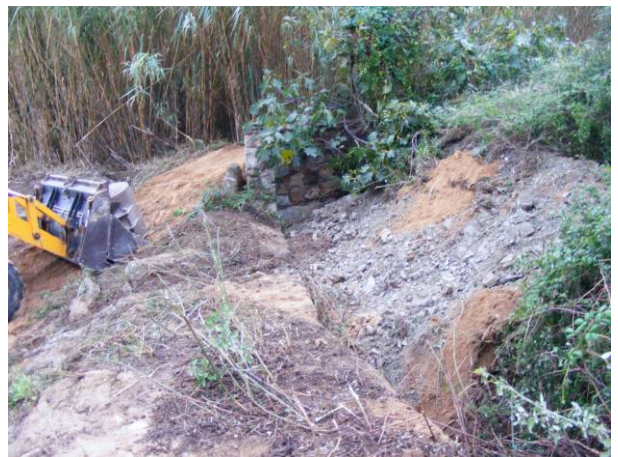
12. Neteja del pont, al costat del Rec Comtal.
