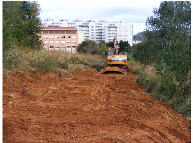
8. Preparació d'un accés abans de l'inici dels sondejos.
