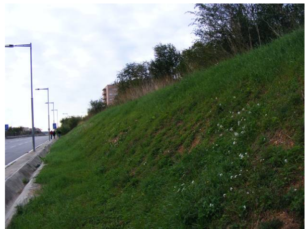
2. Àmbit de l'actuació abans de l'inici dels treballs, des del N.
