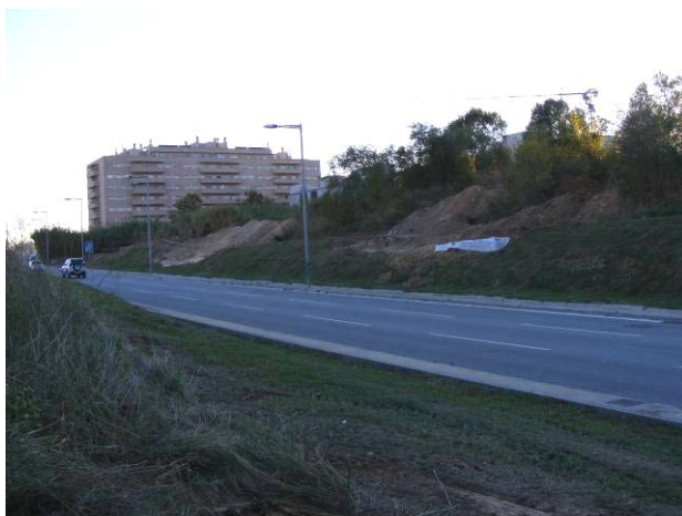
49. Sondejos 200 i 300 coberts amb geotèxtil.
