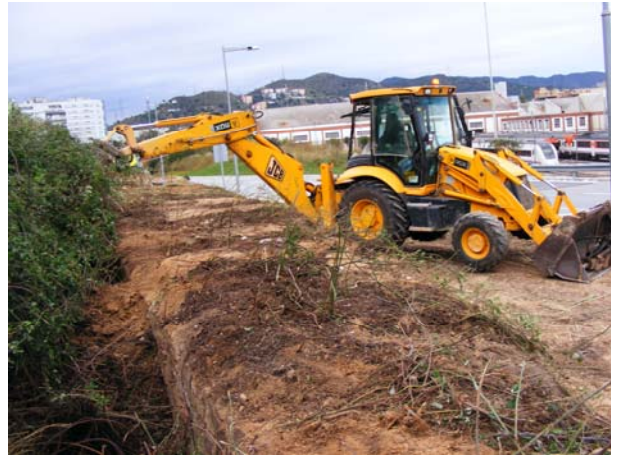
14. Tasques de delimitació del mur est del Rec Comtal.
