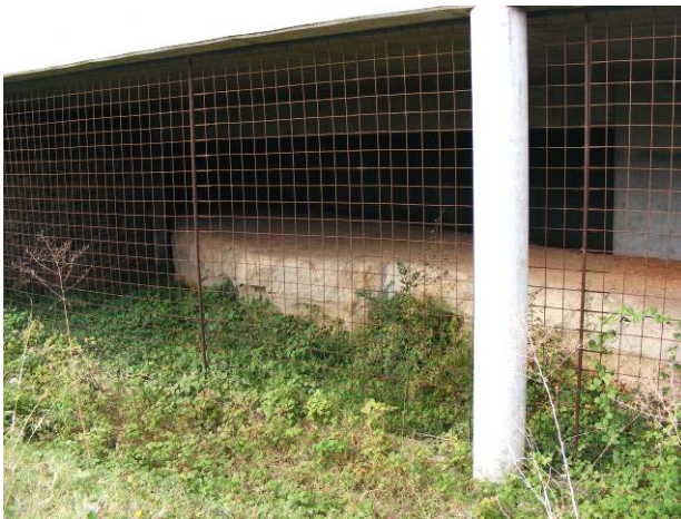
3. Vista de l'aqüeducte localitzat en l'excavació del 2004.
