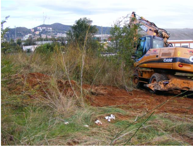
7. Tasques de desbrossament abans de l'inici dels treballs.
