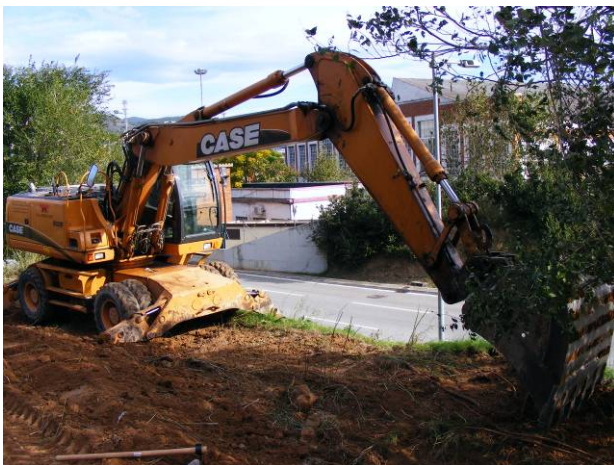
39. Inici sondeig 500, al costat nord de l'àrea d'intervenció.
